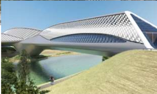
Pabellón Puente Zaragoza, Spain
